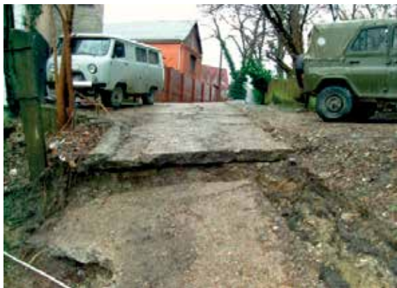
Рис. 1. Оползень в МО Туапсинский район
